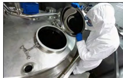
Résistance dans un environnement chimique corrosif
