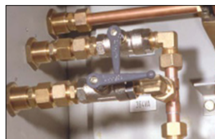
Assemblage modulaire avec tube en cuivre dans un environnement restreint
