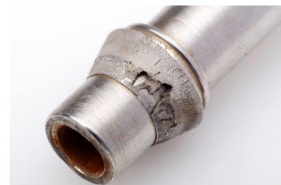
Figura 1. Estos racores de compresión de doble férula (fabricados a partir de 316) se extrajeron de un recorrido de tubería 6MO que había estado en servicio cerca de la costa durante unos nueve meses e ilustran los problemas potenciales de tomar decisiones sobre racores puramente en términos de coste solamente.
