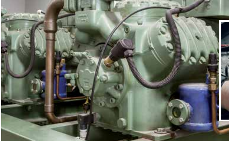
Preimpostazione o regolazione di un interruttore di pressione su un compressore
