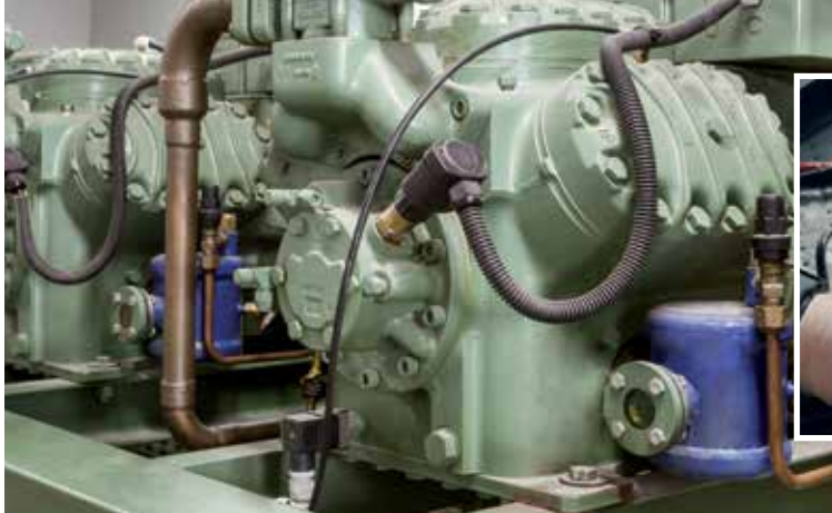
Voreinstellen oder Justieren des Druckschalters eines Kompressors
