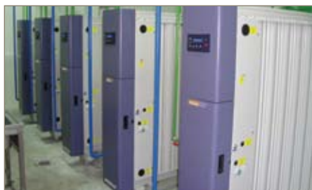
Instalación de varios bancos
