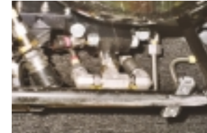
Moderner "Unterbodenschutz" im F-Cell Fahrzeug: O-Lok Verschraubungen von Parker sorgen für Leckagesicherheit.
