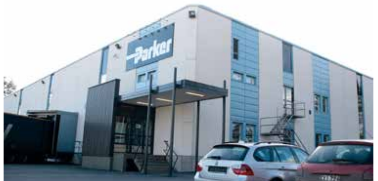
Parker Hannifin Oy:n tehtäät sijaitsevat Suomessa Forssassa (ylin kuva), Urjalassa, Tampereella sekä Ylöjärvellä.
