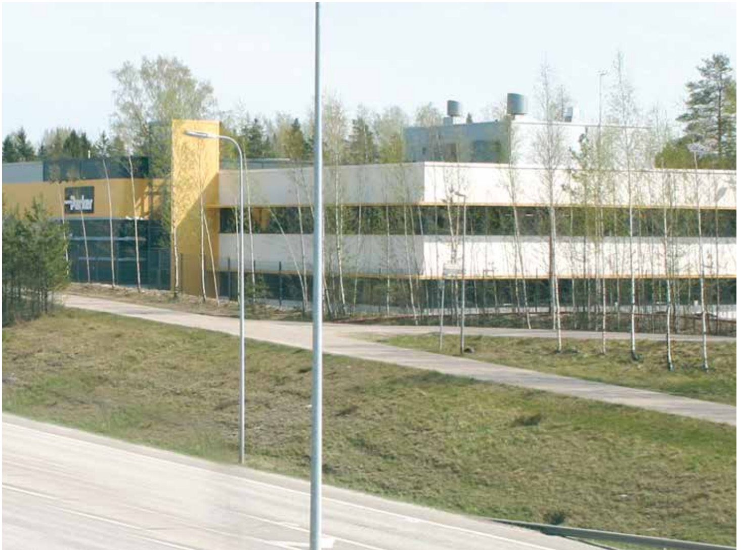
Parker Hannifin Oy:n päätoimipaikka sijaitsee Vantaalla.
